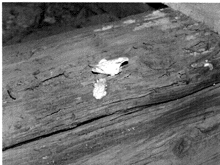
10. ábra barnakorhadás és lemezes fenyőgomba együttes károsítása
