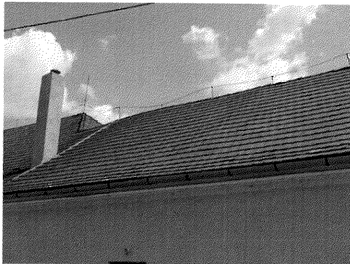
3. ábra A tetősík egyenetlenségei
