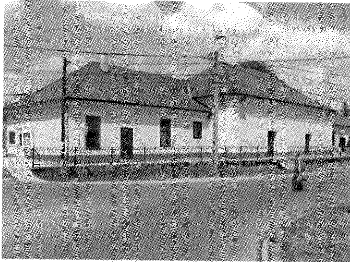
2. ábra Az épület jelenlegi utcai homlokzata
