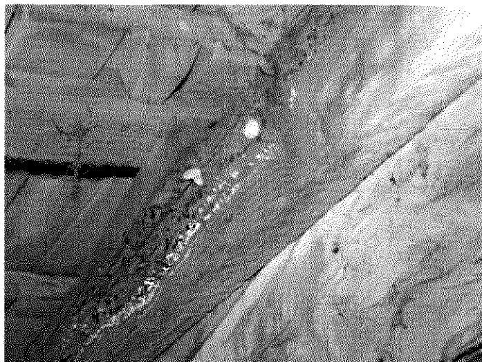
9. ábra Fenyő lemezes gomba károsítása a szarufán
