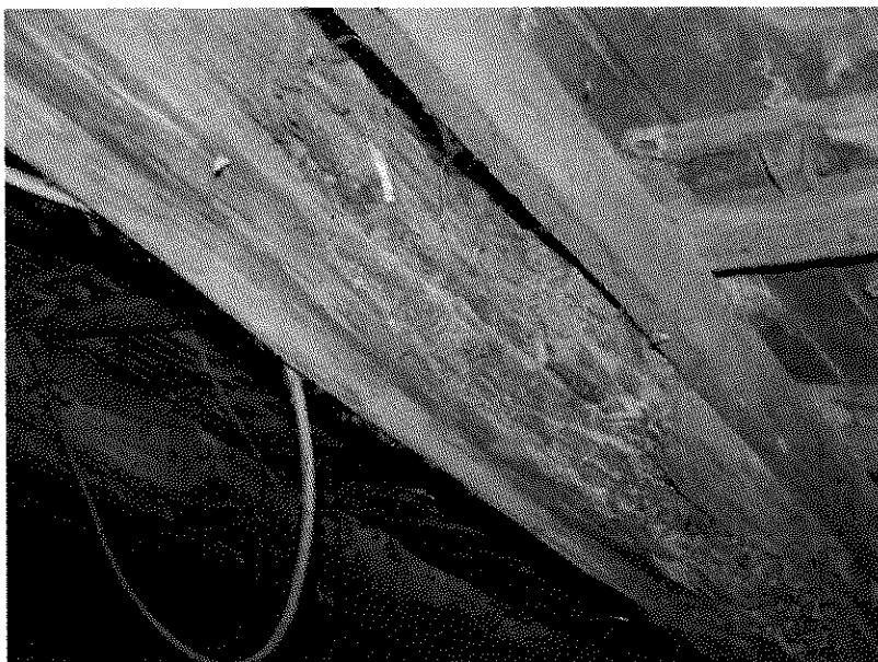
5. ábra A szaru fertőzött eleme
