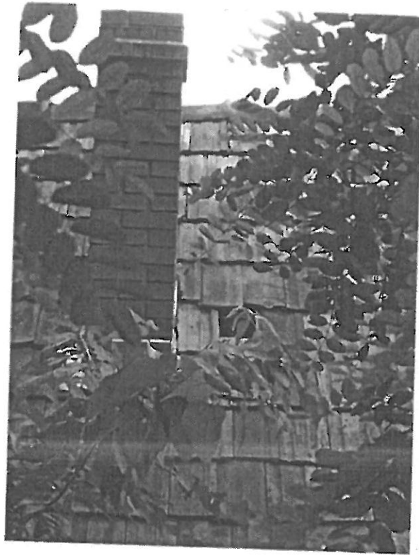
Az épület hátsó tető és a kémény
